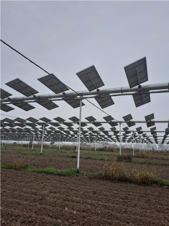
Piacenza, impianto REM tec con tracker
