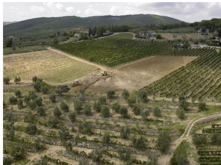
Foto: Settembre 2007 - Preparazione del terreno per nuovi vigneti in Chianti. In basso, vecchi terrazzamenti con viti alternate a olivi
